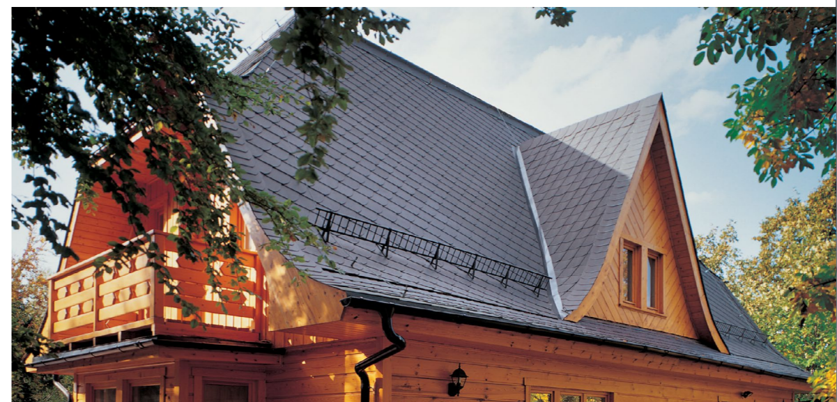
Nemški način pokrivanja (z dvignjenimi vrstami) pokrivanje strehe
